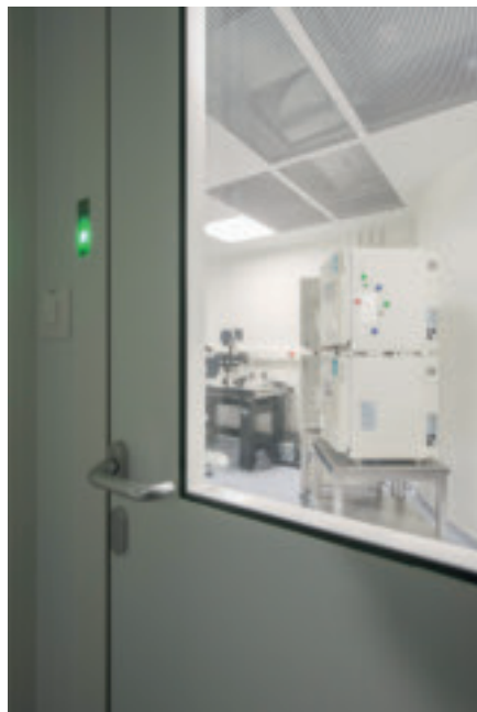
Abb. 6. Überdruck mit Schleusensystem
